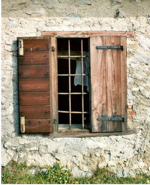
Particolare della finestra originaria non sostituita dai recenti interventi.
