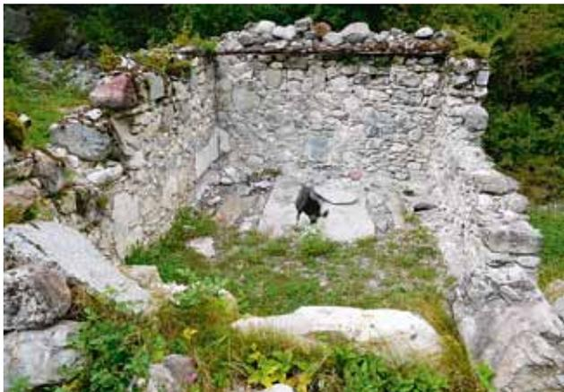
*Il mulino di Iron: a pavimento, le lastre di copertura del canale con il foro per l'albero di trasmissione della ruota orizzontale.*
