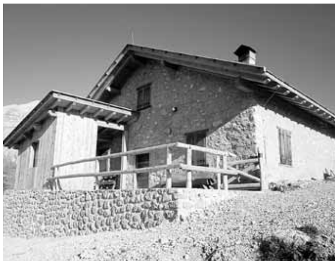
Casina e porcilaia della malga Boch
